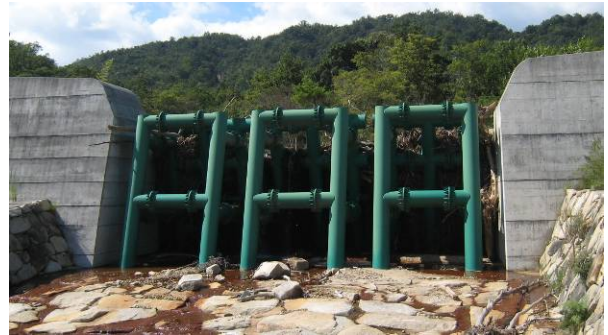
写真-1 鋼製透過型砂防堰堤
