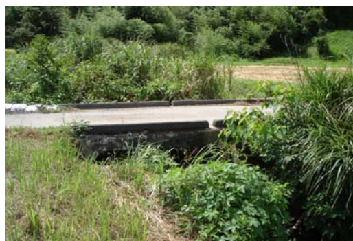
図 - 3 (a) 馬登川上流域に架かる橋梁
