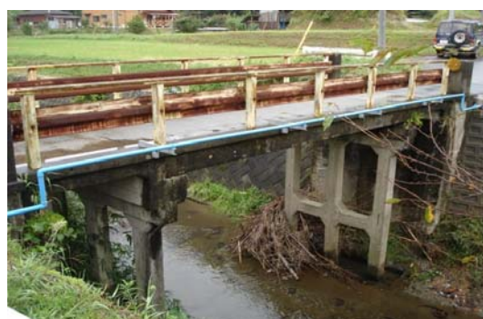
図 - 3 (b) 埴生川に架かる同一形式の橋梁
