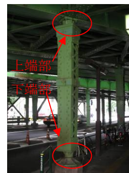
写真-1 鋼製橋脚ピボット支承
