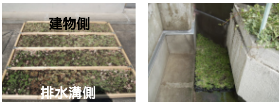
図-2 施工直後の実施場所
