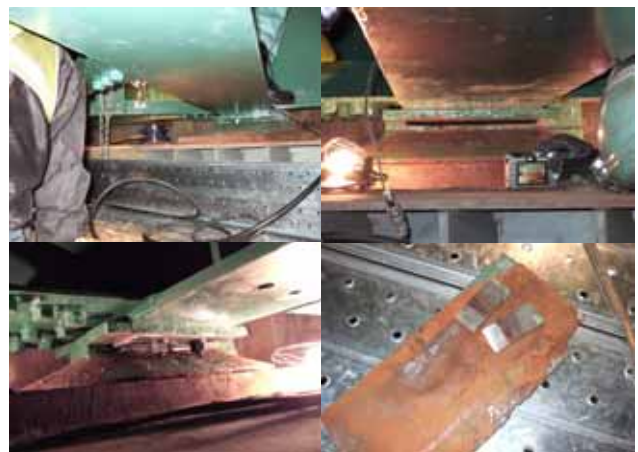
写真—4) 左上: ジャッキアップ状況 右上: HTB 撤去、清掃後の隙間 左下: 厚さ 8.3mm の PL 挿入、右下: 応急で挿入した PL と過去に挿入したプレート
