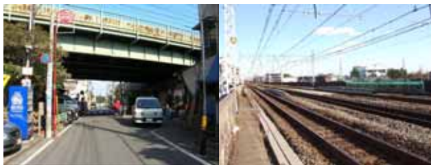
写真—1) 本宿架道橋状況写真
