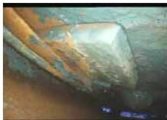
写真—3) 挿入したプレートのズレ
