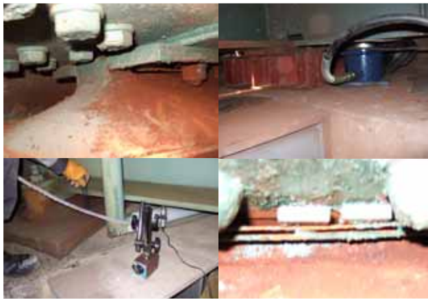
写真—2) 左上: G3 沓座状況 右上: 使用した油圧式ジャッキ 左下: ダイアルゲージによる計測 右下: 挿入したプレート
