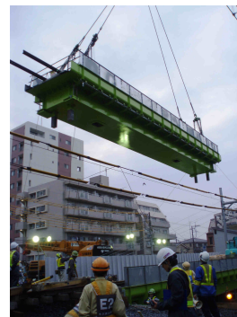
写真-2 新桁架設状況
