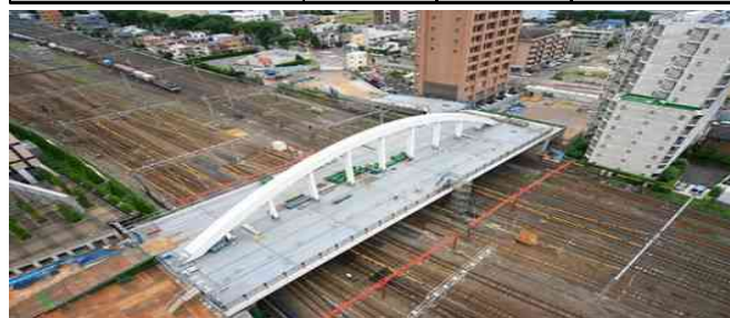
図-4 新橋架設完了状況
