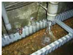
写真 4-2 水抜きパイプ吐き口
