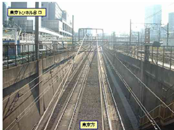
写真-1 軌道扛上箇所
