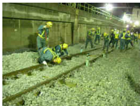
写真-7 バラストによる扛上
