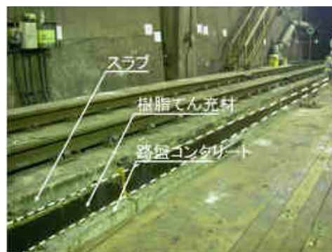
写真-5 スラブ軌道扛上
