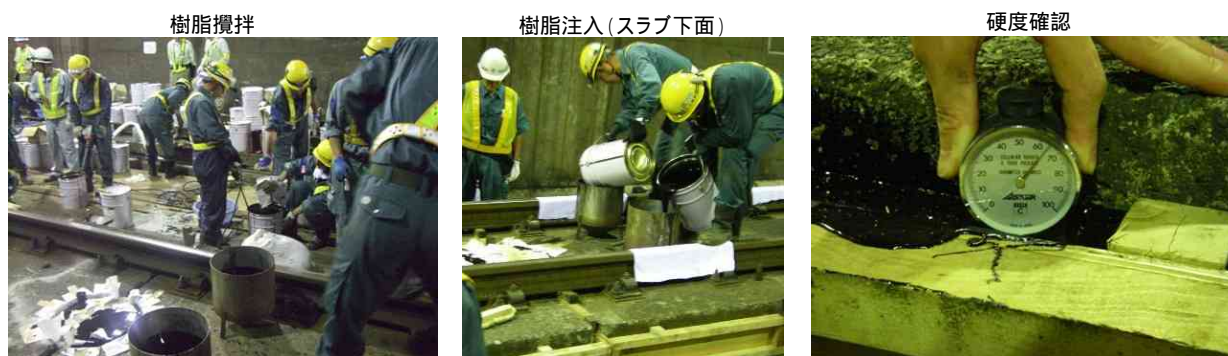
写真-4 施工状況
