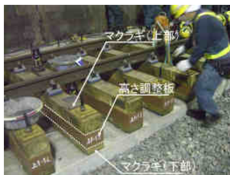
写真-6 高さ調整板による軌道扛上
