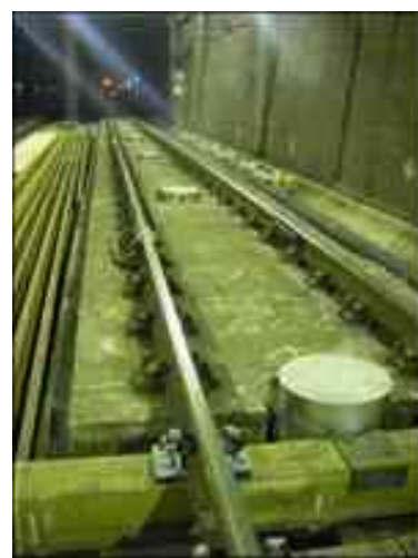
写真-3 突起コンクリート嵩上げ
