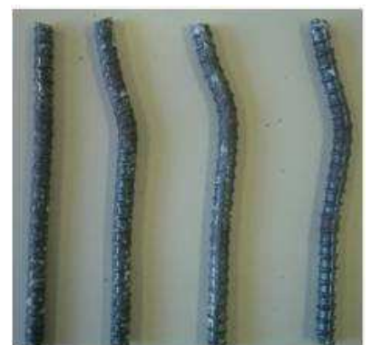
写真-2 載荷後の挿し筋の状態
