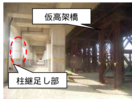
写真-1 段階施工部(高架下)
