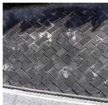
写真-1 間知ブロック練積み造 1)
