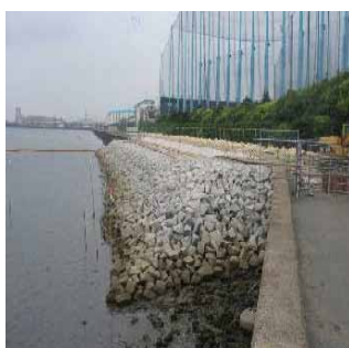
図-2 石積み護岸
