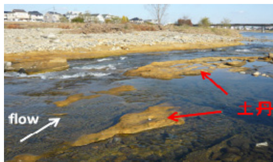
写真-1 浅川 13k 付近の河床状況
