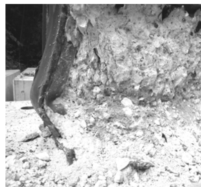
図 - 5 試験体内部の様子(試験体 A)
