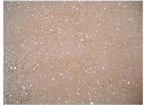
写真-2 牡蠣殻混合率35%の地盤舗装
