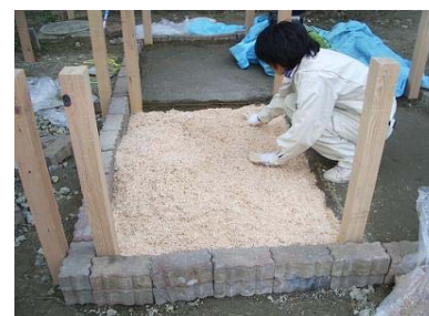
写真-1 舗装施工
