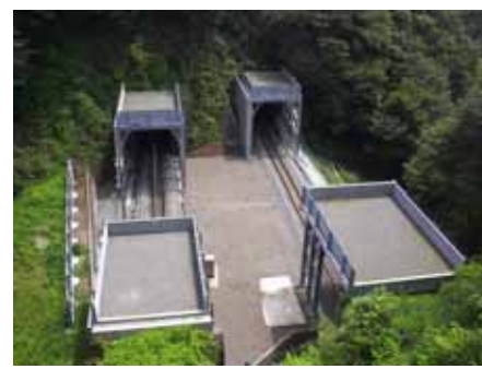
図-7 施工完了状況
