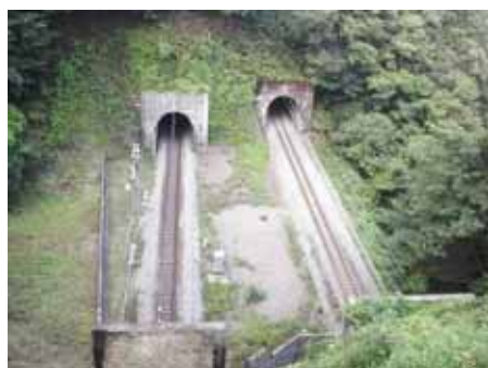
図-5 施工前状況
