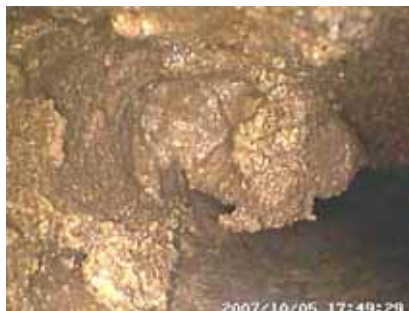
写真-2 水抜き孔内状況
