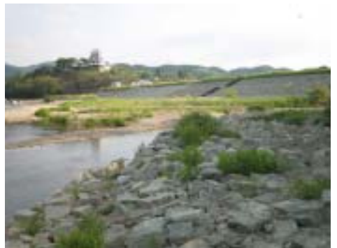
写真-5 施工後1年半（愛媛県肱川）
