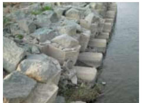
写真-6 水際部（既設ブロックあり）
