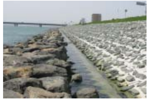
写真-3 現場製作の事例（徳島県吉野川）
