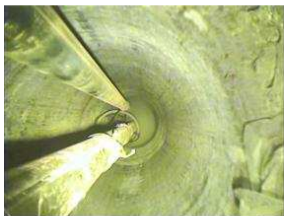
写真-4 杭切断状況（切断時）
