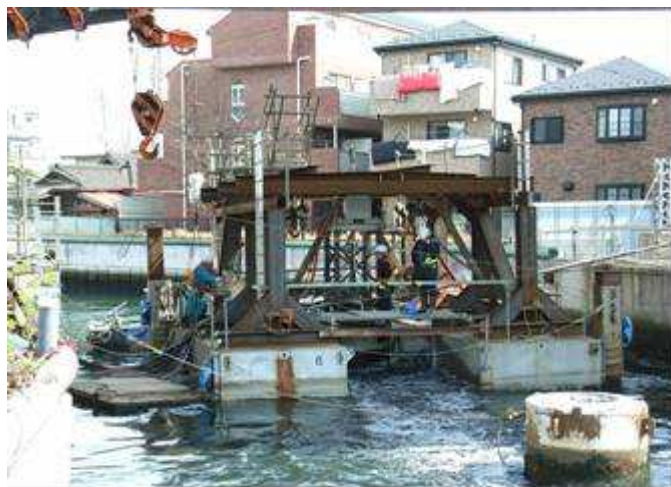
写真-2 橋脚用場所打ち杭切断状況
