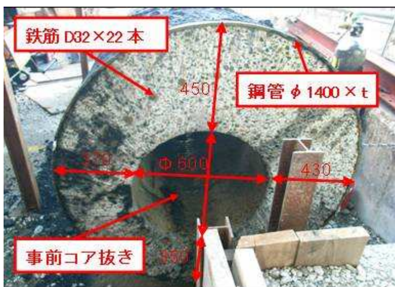
写真-5 杭切断面状況
