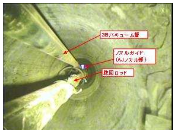
写真-3 杭切断状況（貫通時）
