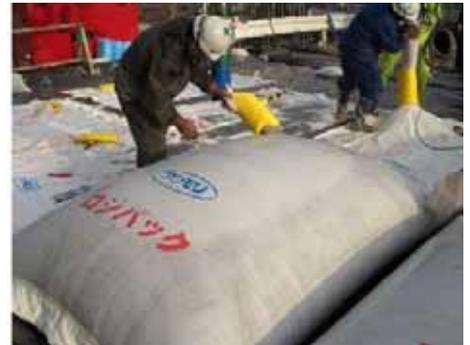
写真-3 汚染土充填状況
