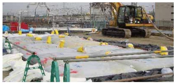
写真-2 有害物質を含む泥土の脱水・減量化
