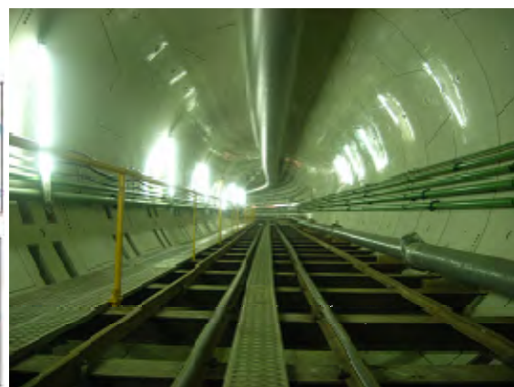
図 2-7 トンネル坑内の状況
