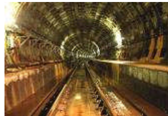
写真1 二次覆工施工前
