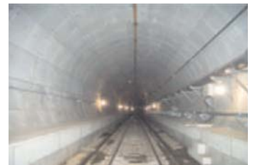
写真2 二次覆工施工後
