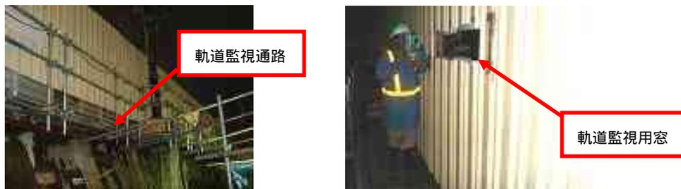
図 - 9 点検通路と確認窓・トランシット測定架台
