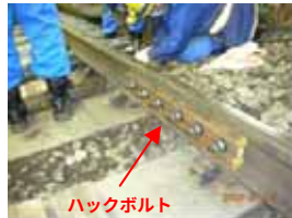
ハックボルト設置後
