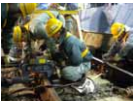
ハックボルト設置状況
