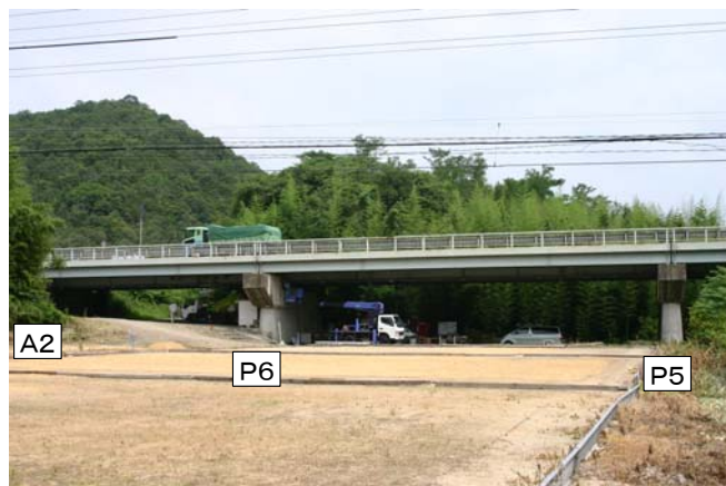
写真-2 測定区間
