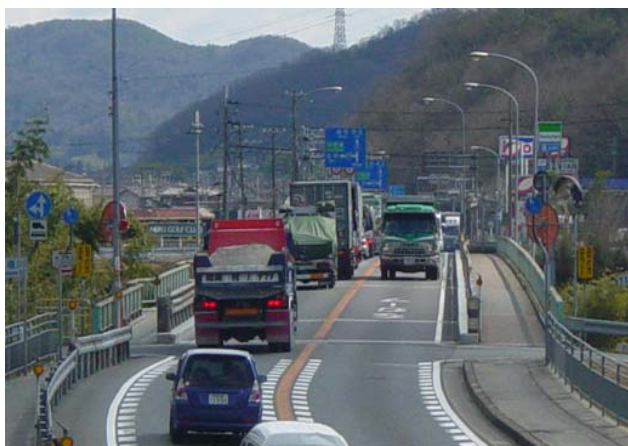
写真-1 道路面の状況
