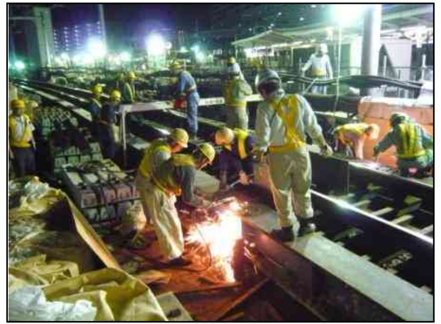
写真-2 工事桁切断
