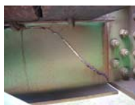
図 1 亀裂発生箇所 (H16 年 3 月)
