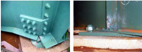
写真 6 a 当板補強と b 再溶接
