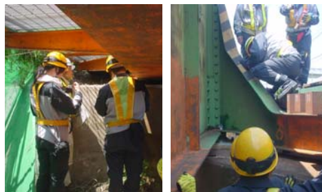
写真 4 塗装足場を利用した検査
