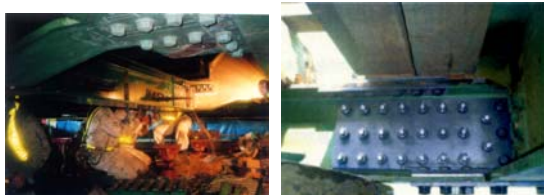
写真 3 当板補強および縦桁交換
