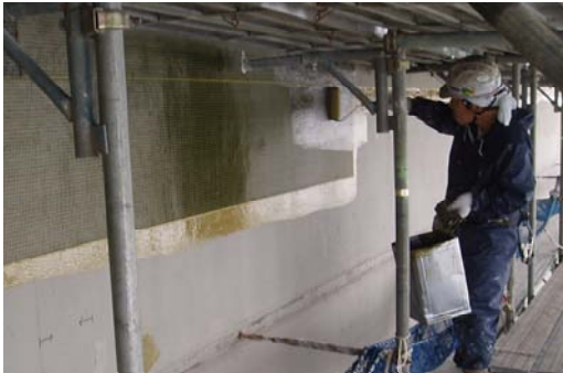
写真-3 炭素繊維シート施工状況
