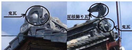
写真-2 鬼瓦(左)と、鬼瓦と屋根飾り瓦(右)
