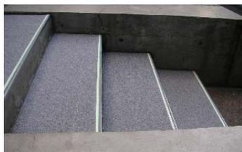
写真3 高輝度蓄光段鼻材の施工事例
