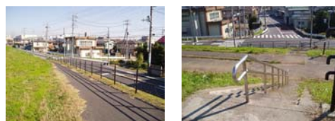
写真-2 江戸川の整備状況（左：スロープ，右：手すり）
