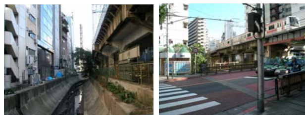
写真一3 渋谷川沿いに設置された私鉄線の高架
