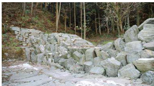
写真1 石丸積による砂防堰堤
