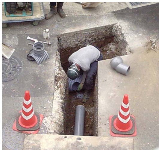
写真-1 補修工事の際の管路布設換え工事によって生じる隅角部を有する溝掘削形状
