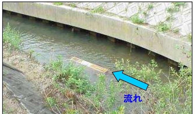
写真-2 挿入直後の水制構造物
