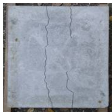
写真-1(b) 裏面 (ひび割れを加筆して強調)
