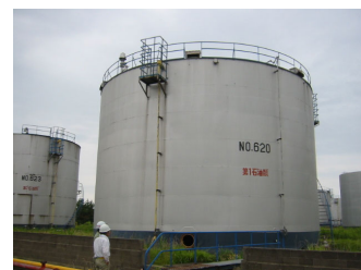
写真1. 1600KL インナーフロートタンク
