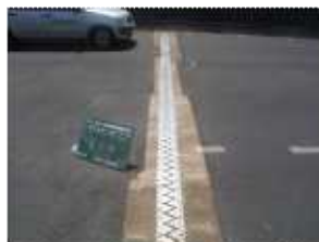
図-3 ジョイント補修前
