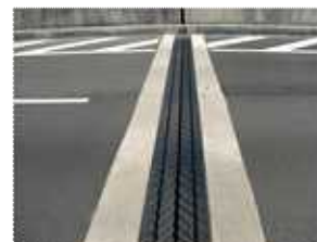
図-4 ジョイント補修後
