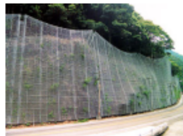
写真-1 落石防護網
