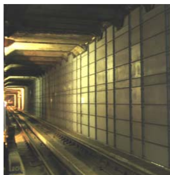
写真-1 囲い込み状況
