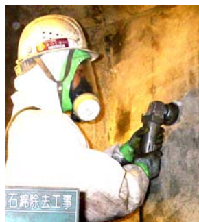
写真-2 石綿除去状況
