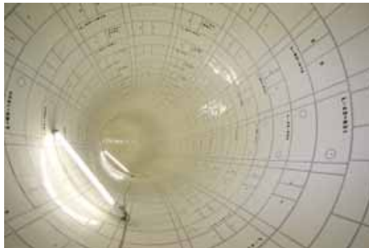
写真 - 1 シールドトンネル内状況
