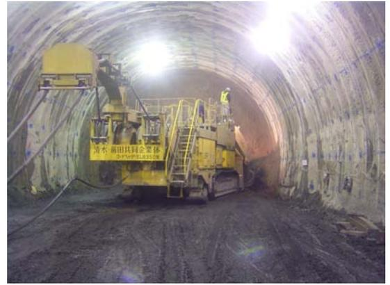
写真-2 補助ベンチ付全断面掘削状況
