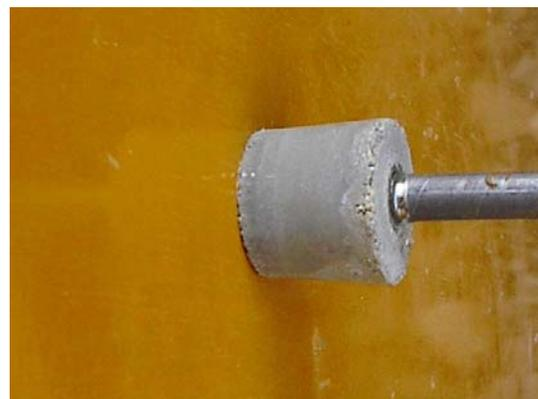
写真-3 防水コーン取付状況
