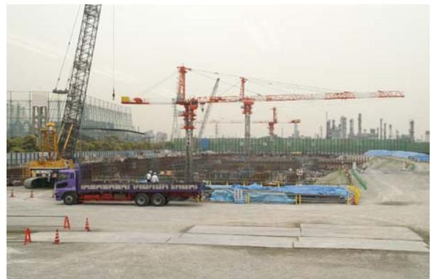
写真-2 水平ジブクレーン
