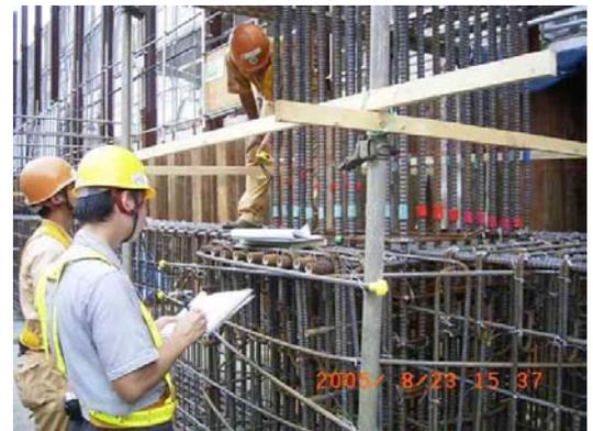
写真 1 鉄筋工施工確認
