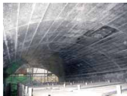
写真6 補強後状況(上床版)
