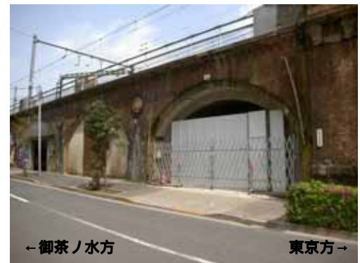
写真1 紅梅河岸高架橋
