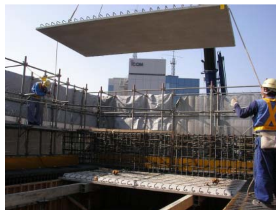
写真-1 PREX スラブの架設状況
