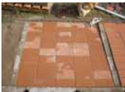
図 2 ブロック敷設写真
