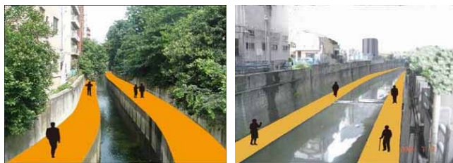
写真-2 河川整備された渋谷川（左）と古川（右）
